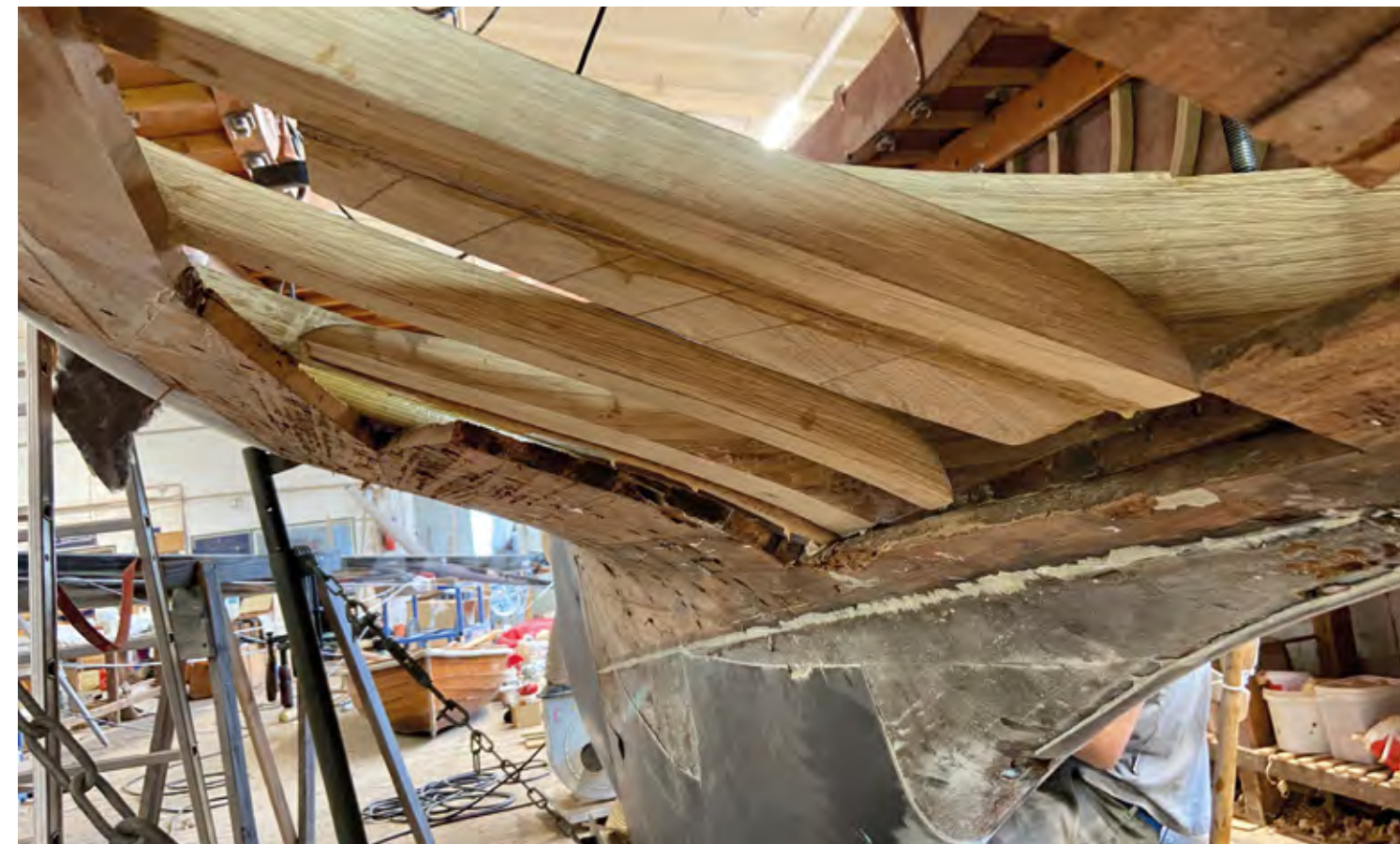
Insgesamt wurden zwischen Ruderkoher und Vorschiff 22 Spanten und elf Wrangen ersetzt.
